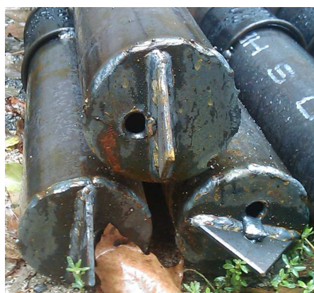
Provedení injektážních otvorů v patě výztužné trubky pro injektáž paty mikropiloty :
