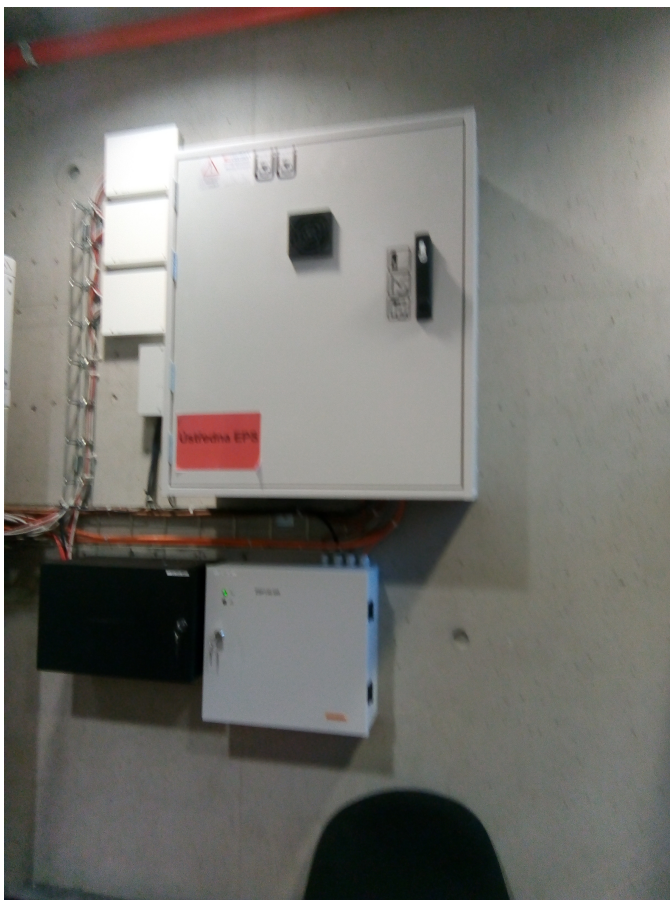
Ústředna EPS v objektu F m.č. BVA06P01001 je místem připojení ústředny EPS objektu E do sítě ústředen ESSERNET.
