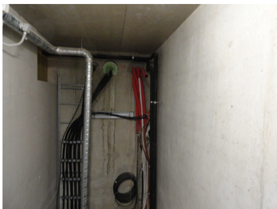
„Kabelová komora“ prostup kabeláže směrem do budovy C
