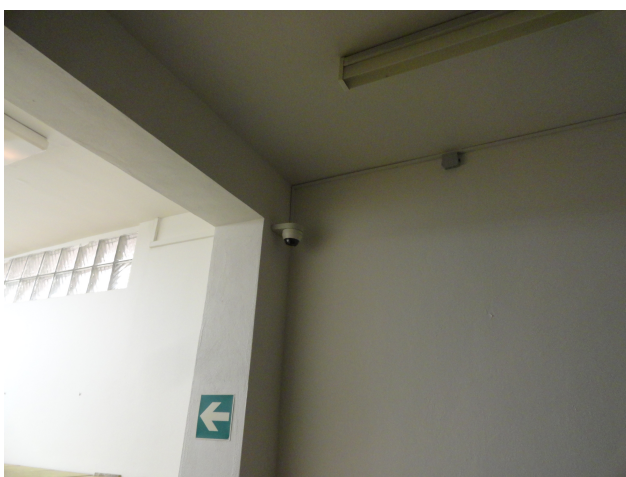
Stávající kamera v objektu E BVA05N01006 bude přeložena pod podhled
