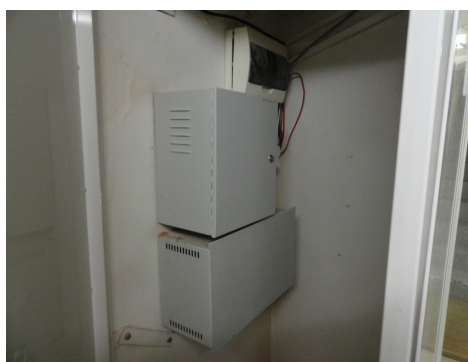
1.PP BVA05P01006 zdroj B pro napájení únikových zámků a zámků EKV
