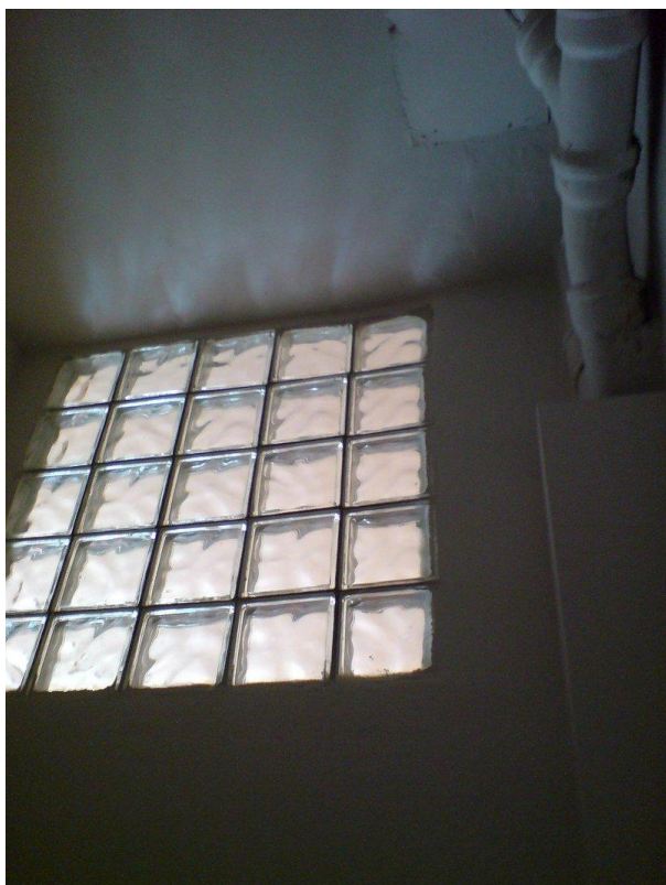
Foto09 – stávající kan.svod a sklen.tvárnice na bezb.wc
