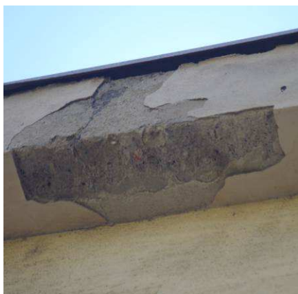
- poškozené žlabové římsy
