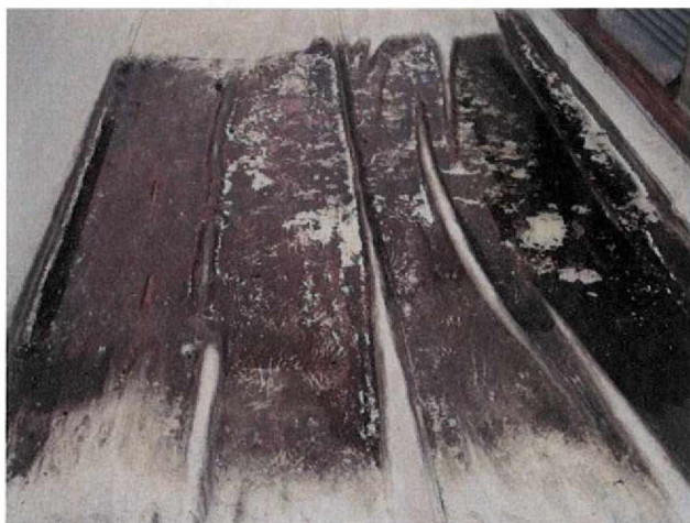
foto /7/ Zvrásněná hydroizolace, stojící voda
