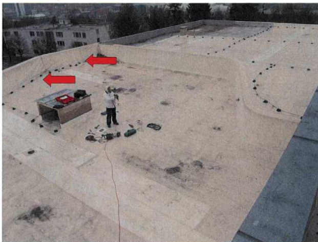
foto /27/ Vyvěšená hydroizolace na atice
