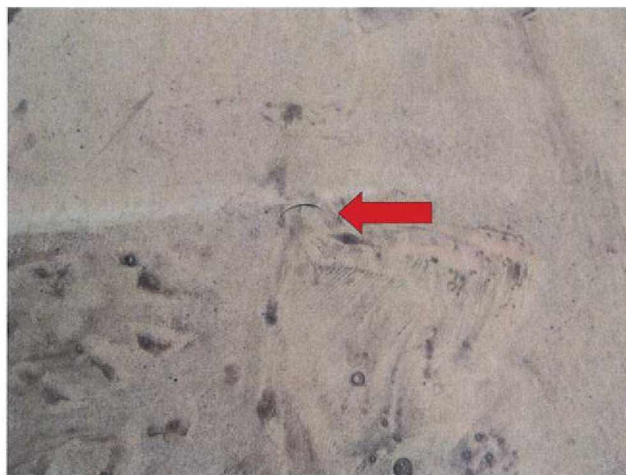
foto /8/ Netěsnost v ploše hydroizolace
