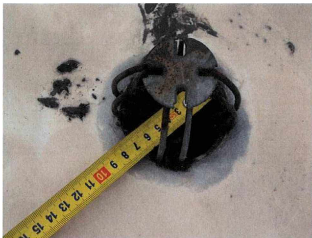
foto /16/ Vnitřní vtok – DN 40 mm
