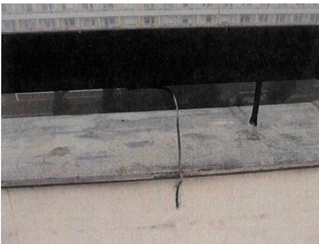
foto /29/ Prostup bleskosvodného lana
