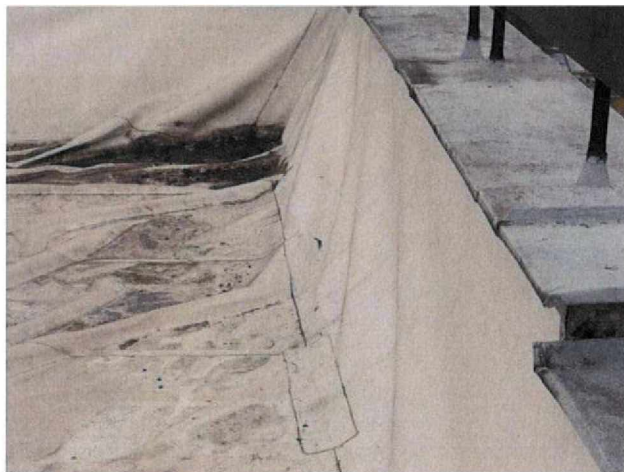
foto /19/ Vyvěšená fólie na atice
