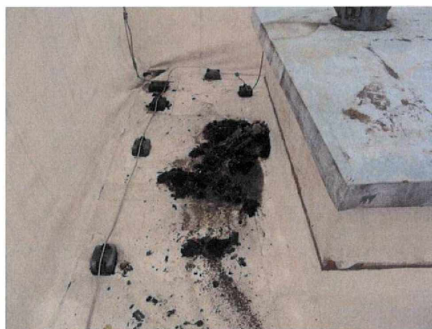
foto /11/ Nánosy nečistot
