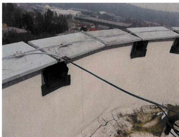
foto /23/ Dodatečná hydroizolace v místě členění
