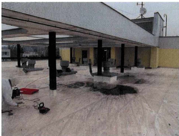
foto /9/ Zvrásněná hydroizolace, stojící voda
