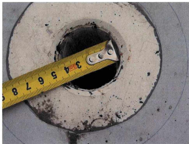
foto /17/ Vnitřní vtok – DN 40 mm
