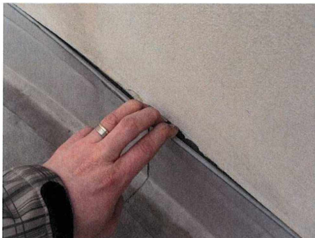
foto /30/ Netěsnost v místě napojení na stěnu
