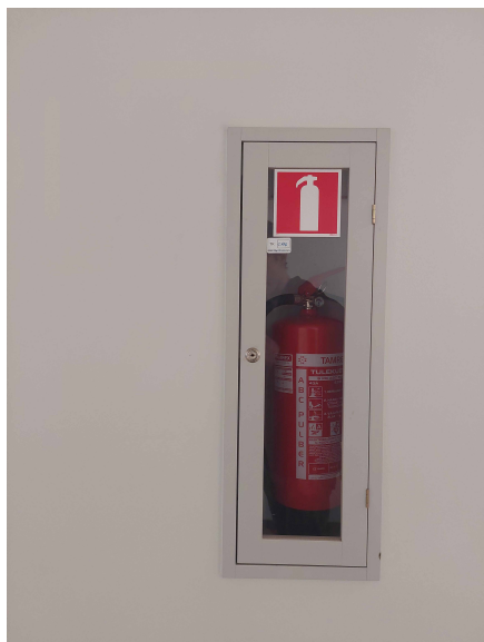
HASÍCÍ PŘÍSTROJ OSAZENÝ V PLECHOVÉM BOXU VÝŠKY 666 mm, ŠÍŘKY 306 mm, HLOUBKY 210 mm KLÍČEK INTEGROVANÝ VE DVEŘÍCH
