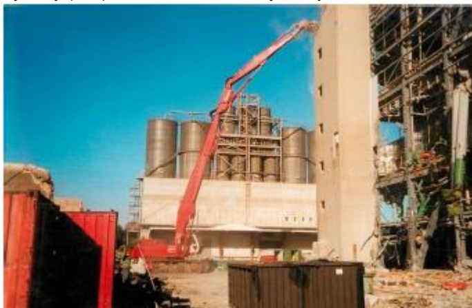
Místo demolice. Zdroj: VERAS
