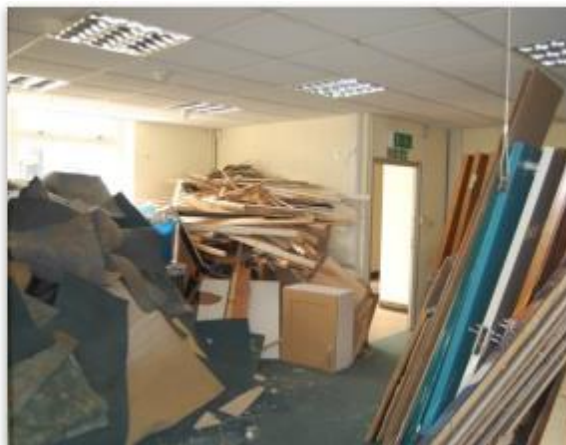
Třídění odpadu v místě demolice, Zdroj: UEPG
