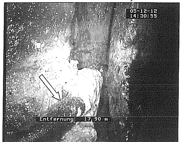
FOTO 002: 17,6m - překážka odtoku, splaškové naplaveniny cca 50% profilu, následně odstraněny
