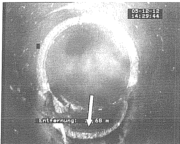
FOTO 001: 6,6m - netěsnost, paprskovité trhliny, celkový obvod v úseku 6,6 - 15,4m, exfiltrace
