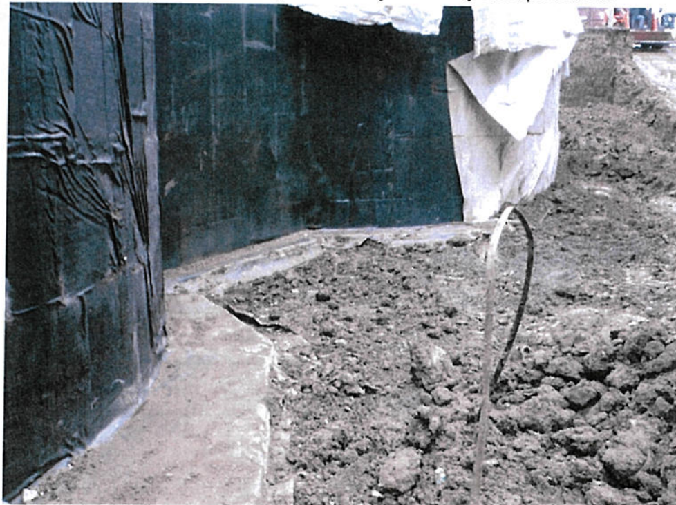
Obr. 2: Přetažené podkladní betony u a severní jižní rotundy NMR pavilonu A4
