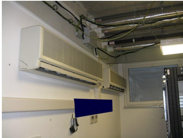
Umístění vnitřní chladicí jednotky 10 kW
