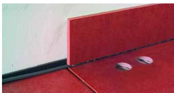
Obr. 12 Dilatační rohová spára
