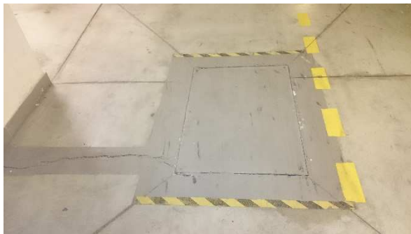
Foto 09: Poškození v místě dilatačního pole.
