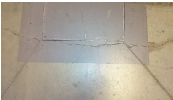
Foto 05: Poškození v místě natačného pole.
