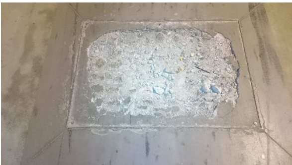
Foto 11: Poškození poklopů v blízkosti objektu A8.
