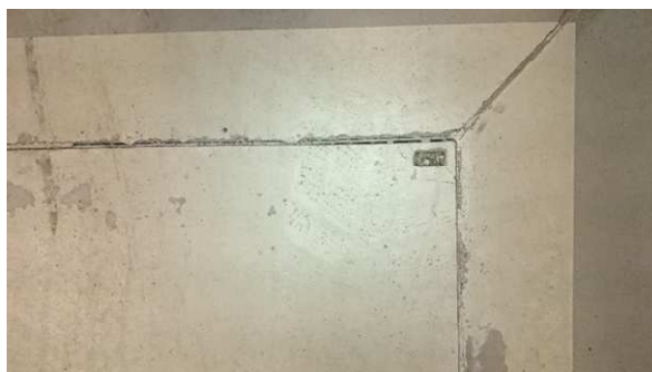
Foto 02: typické poškození výplně poklopů – rozpraskání a vydrolení výplně u rámu.
