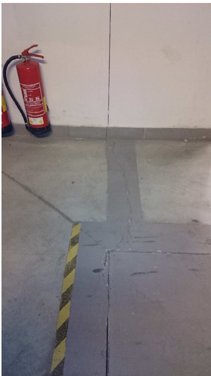
Foto 08: Poškození v místě dilatačního pole.
