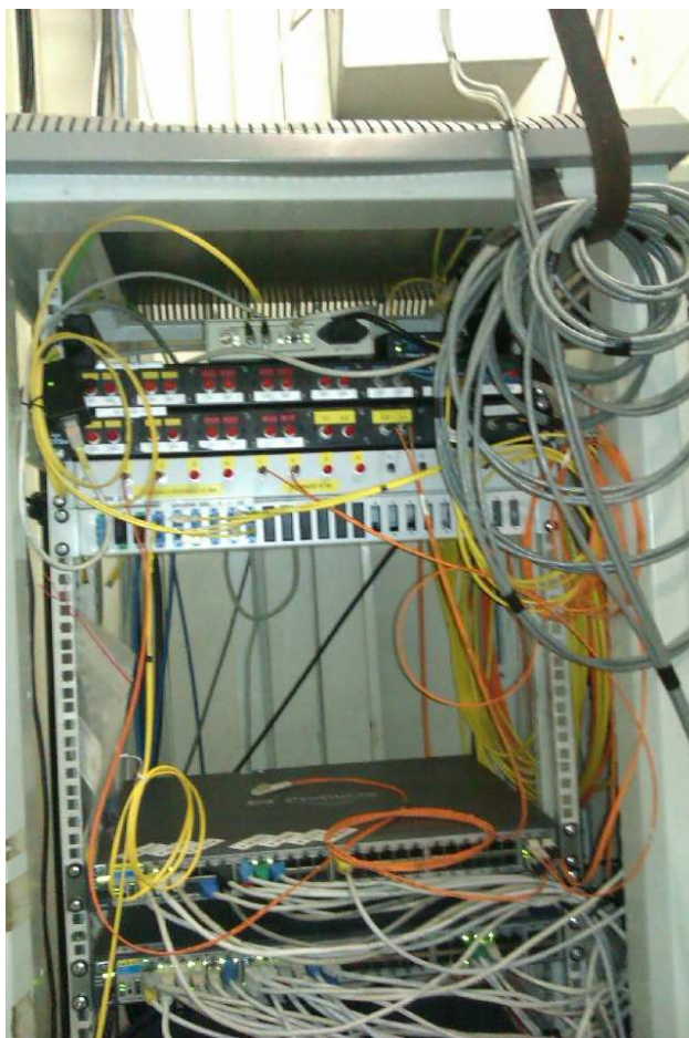
- optické připojení do B115, B, 1.NP, optika 16x9/125, zakončena 4 vlákna. Foto 3.
