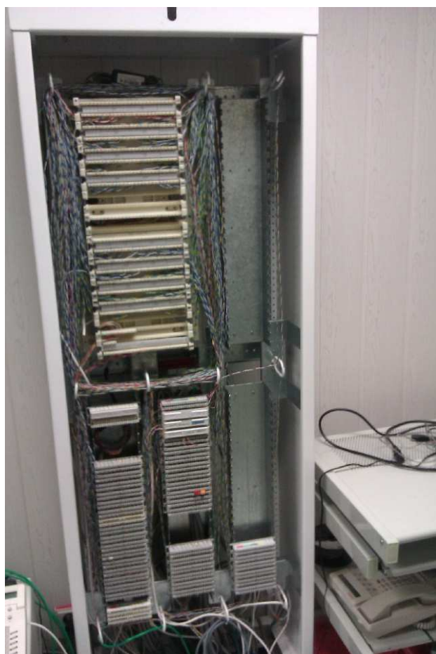
- propojení metalickými kabely k telefonní ústředně, stávající m.č. C140, obj.C, 1.NP. S ohledem na rozšiřování pobočkové ústředny o 120linek pro A1, má páteř dimenzi 3x50x0,5 (150tlf. párů). A2 -240tlf. párů - 5x50x0,5. Ukončení na Krone LSA10p. K dispozici je cca 40 zubů na stávajícím držáku svorkovnic Krone. (Zde ukončen propoj do B). Foto 4. Strana ústředny a multipárové kabely z A1, A2 jsou ukončeny na rámu v novém rozváděči.
