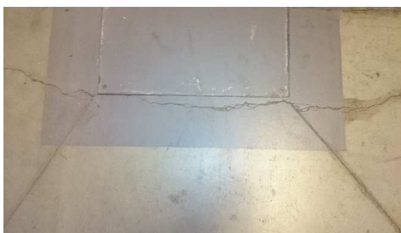
Foto 05: Poškození v místě upevňovacího pole.
