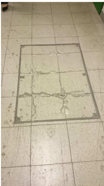
Foto 03: Poklop u vstupu do objektu A13 – nášlapná vrstva dlažba.
