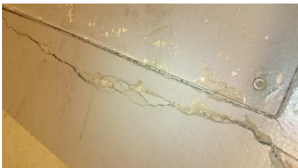
Foto 06: Detail poškození typického poklopu.
