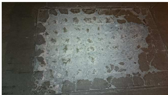
Foto 12: Poškození poklopů v blízkosti objektu A10.
