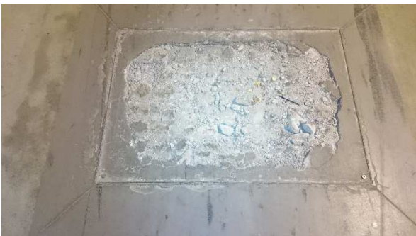
Foto 11: Poškození poklopů v blízkosti objektu A8.
