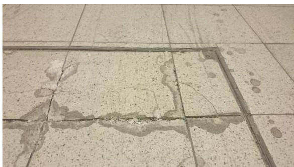
Foto 04: Detail poškození poklopu u objektu A13.
