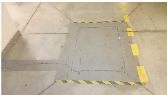
Foto 09: Poškození v místě dilatačního pole.
