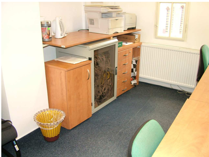
Datový rozvaděč s připojením do metropolitní sítě MU v 2.NP.
