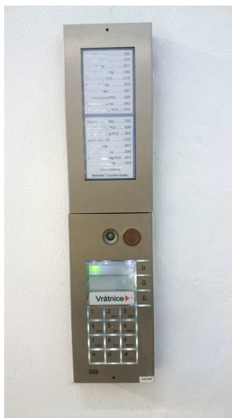
Interkom s vestavěnou čtečkou, ovládacím tlačítkem a signalizací
