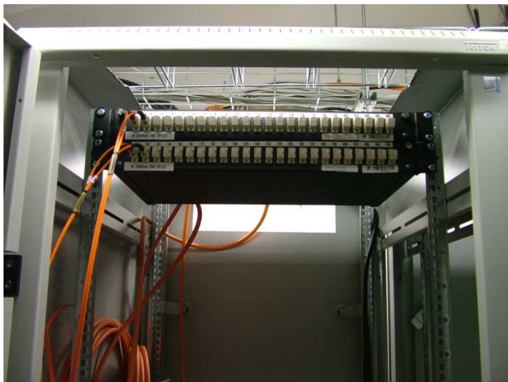
R5 - navrhované zakončení kabelu WTO KN2 – J13, SM 9/125 v nové optické vaně na konektorech E2000.
