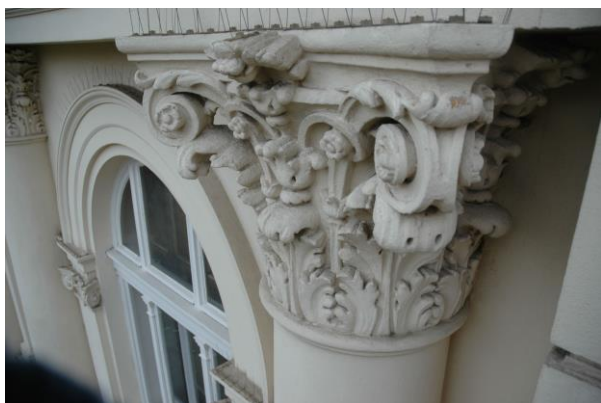
Vzorek E – výstavba povrchových úprav korintské hlavice polosloupu zhotovené z pískovce při makroskopickém zvětšení.
