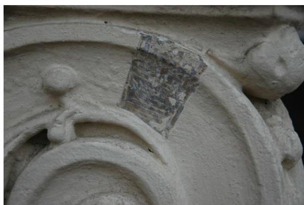
Vzorek D – výstavba povrchových úprav dekorativních prvků zhotovených z románského cementu při makroskopickém zvětšení.
