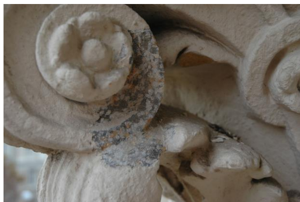
Vzorek E – výstavba povrchových úprav korintské hlavice polosloupu zhotovené z pískovce při makroskopickém zvětšení.
