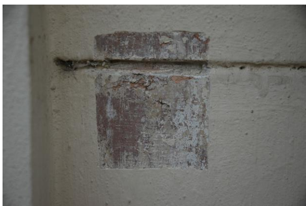
Vzorek F – výstavba povrchových úprav profilací z románského cementu při makroskopickém zvětšení .
