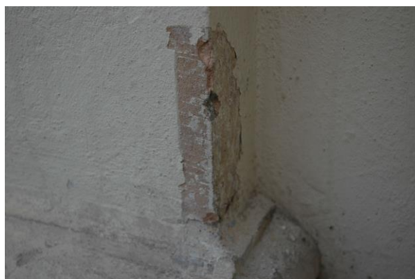
Vzorek F – výstavba povrchových úprav profilací z románského cementu při makroskopickém zvětšení .
