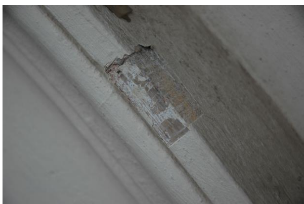
Vzorek D – výstavba povrchových úprav dekorativních prvků zhotovených z románského cementu při makroskopickém zvětšení.
