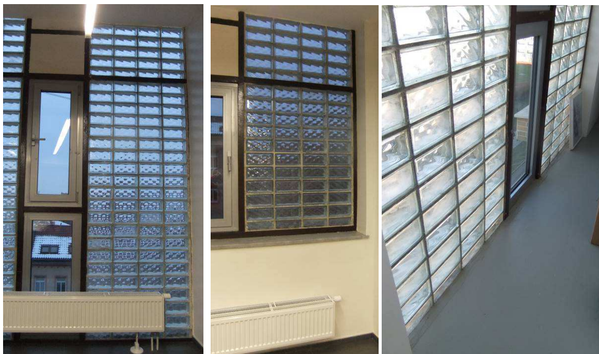
- sklobetonové konstrukce (vnitřní pohled)
