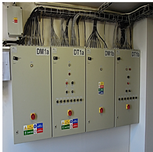
Obr. 2 – SESTAVA ROZVADĚČŮ MaR VE STROJOVNĚ VZT
