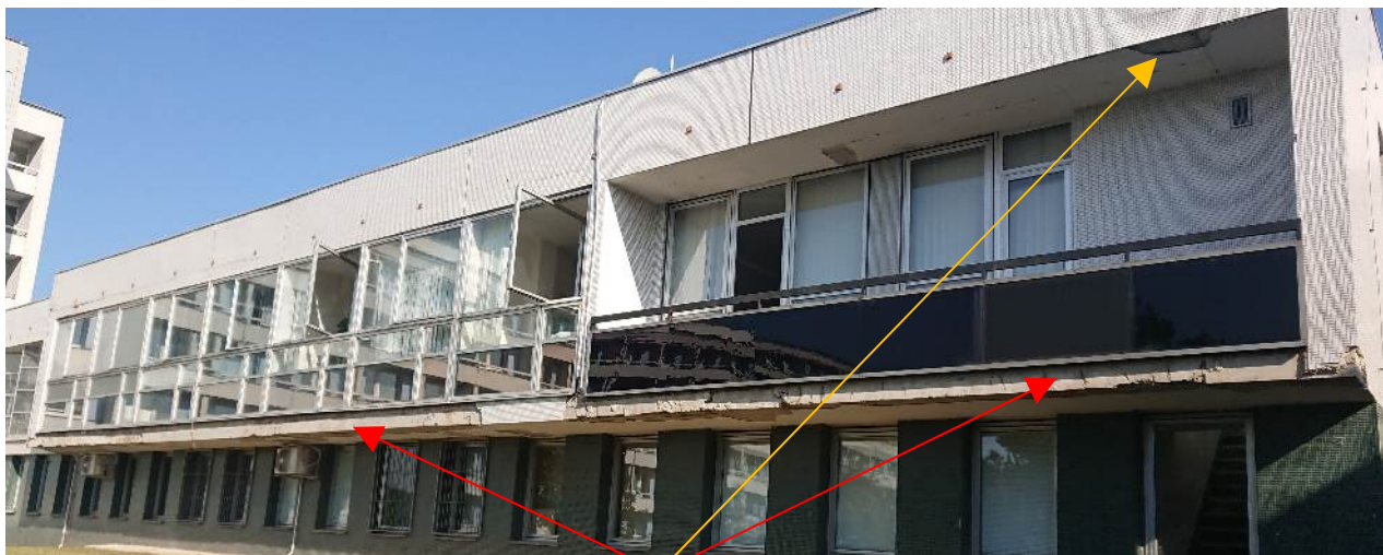
- typické defekty jižních fasád (opadávání fasádního obkladu a omítek)
