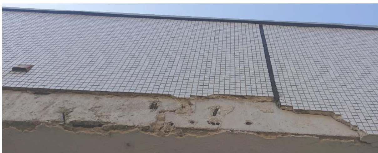
- defekty u přechodu z podhledu na svislé plochy fasády
