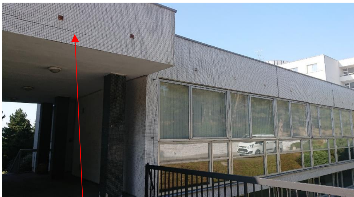
- defekty atikových částí
