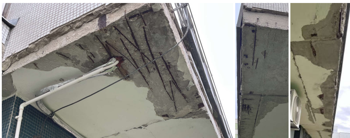
- poškození krycí vrstvy a obnažení armatur ŽB konstrukcí
