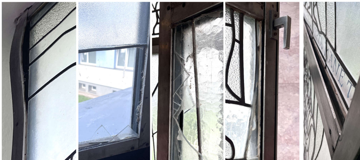
- defekty vitráže a ocelové konstrukce
